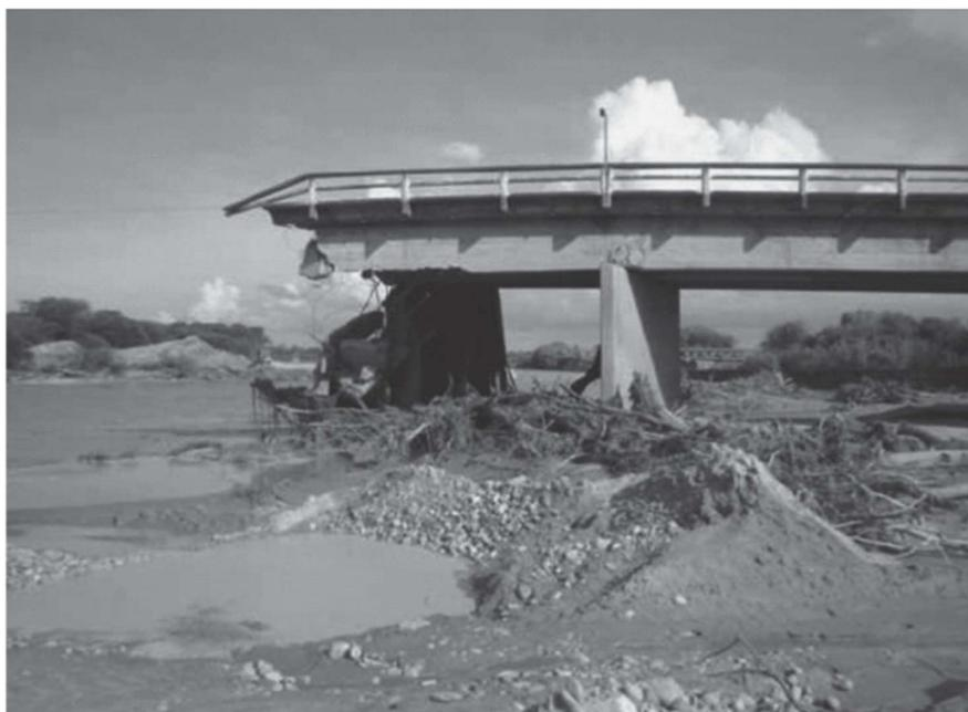
**Figura 15.** Puente destruido por una tormenta y deslizamiento en Tartagal, Salta. Fuente: Latrubesse y Brea (2009).
